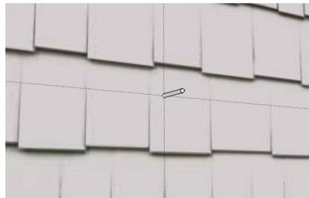
À l'aide d'une scie-cloche, guidez-vous sur l'avant-trou pour percer le trou de 6 1/4 po.
